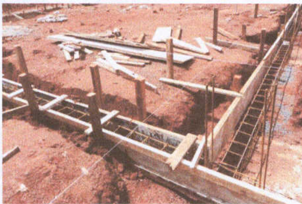
Imagens 01 e 02 – Estrutura de concreto armado moldada no local
