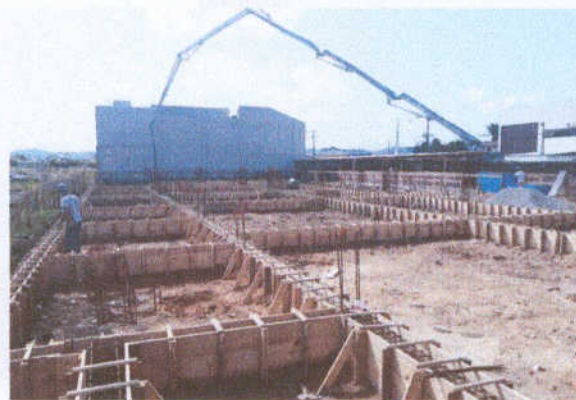
Imagens 01 e 02 – Estrutura de concreto armado moldada no local
