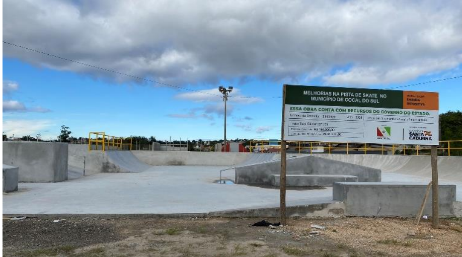
Figura 58 - Obra da pista de skate.
