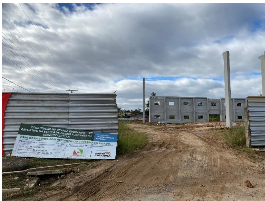
Figura 57 - Obra da arena multiuso da escola Demétrio Dettiol.
